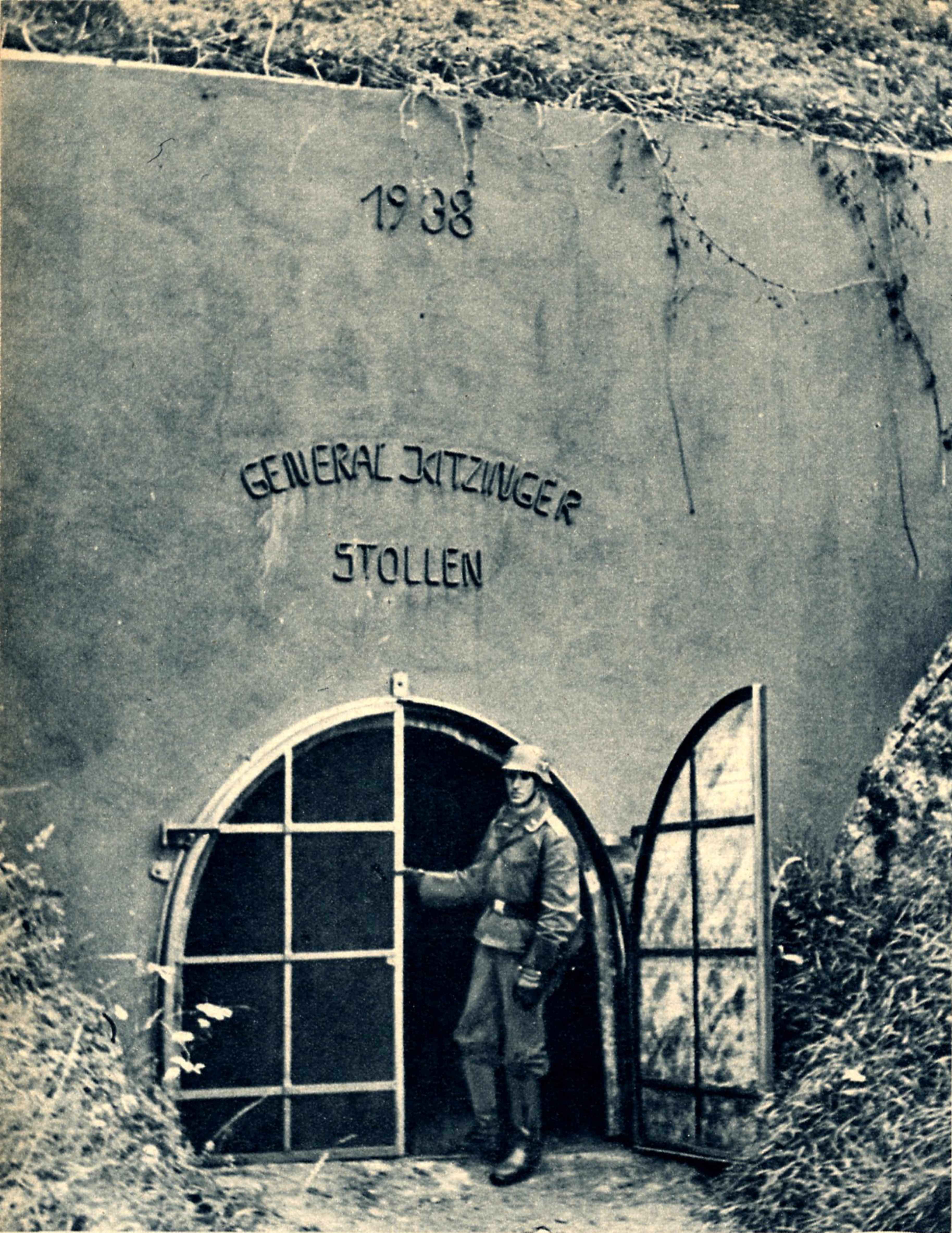
Eingang zu einem Stollen in der Luftverteidigungszone, der tief in den Berg hineinführt und einer ganzen Kompanie absolut sichere Unterkunft bietet. Es versteht sich, daß der Stollen einen zweiten Ausgang hat
